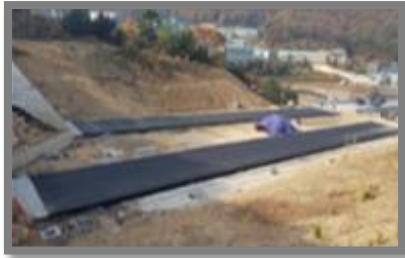
저비용 롤러전압 다짐 콘크리트 포장 공법
