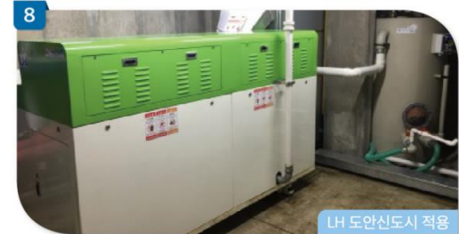
LH 도안신도시 적용 주거단지(발생원) 내 자체 음식물쓰레기 처리시스템
