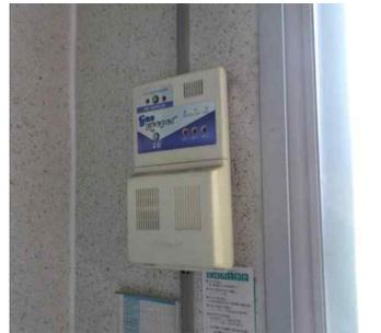
가스누출경보 차단장치 미설치 및 전원 OFF 상태
